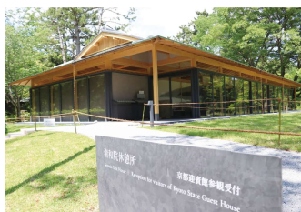
清和院休憩所（外観）
